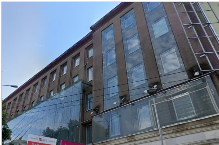
Joonis 6. Klaasitud topelfassaad ning lisaklaas avatäidete ees. Allikas: Google Maps, Estonia pst 1, Tallinn
